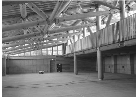
活用事例（三国町艇庫）
