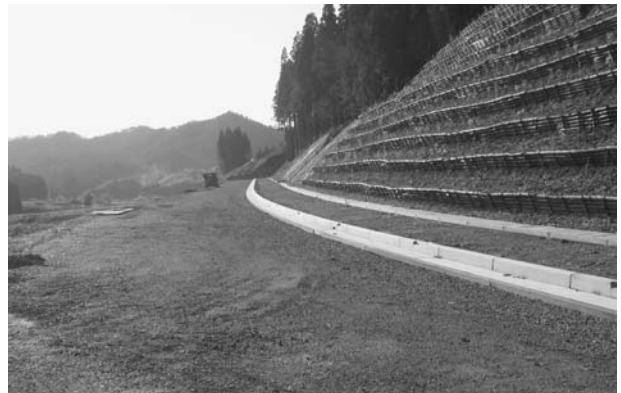
吉野瀬川ダム建設工事現場
