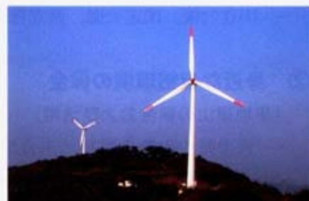
福井市国見岳風力発電所
