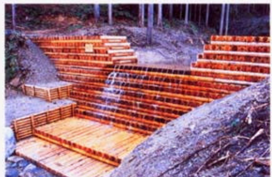
木製治山ダム
