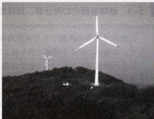
福井市国見岳風力発電所
